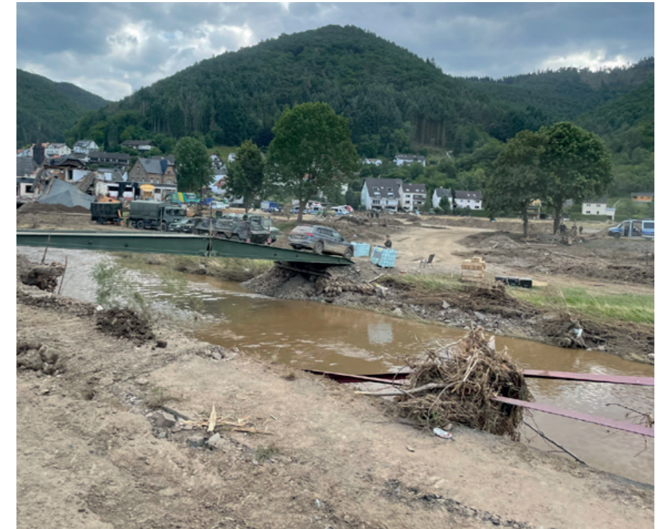
Mayschoß in Rheinland-Pfalz am 29. Juli 2021: Durch Starkregen ausgelöste Fluten haben viele Häuser in dem Ort komplett zerstört oder stark beschädigt.
