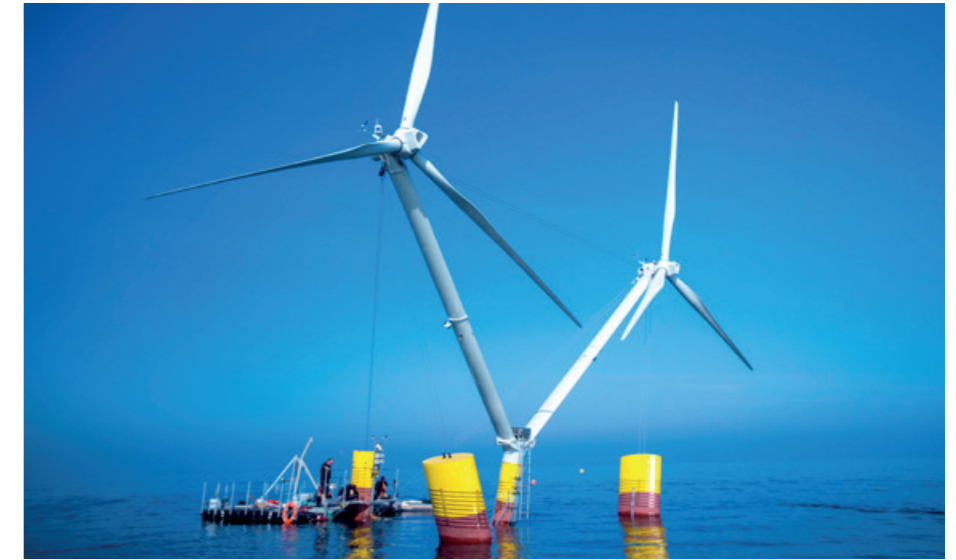
Montage von schwimmenden Windrädern vor der Greifswalder Küste: Regenerativer Strom wird in Deutschland vor allem offshore in der Nord- und Ostsee produziert.
